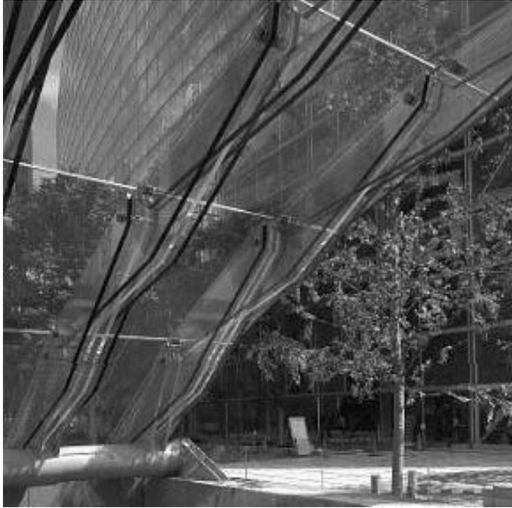
Figure 2 : Détail des poutres et assemblages de la voûte en verre trempé
