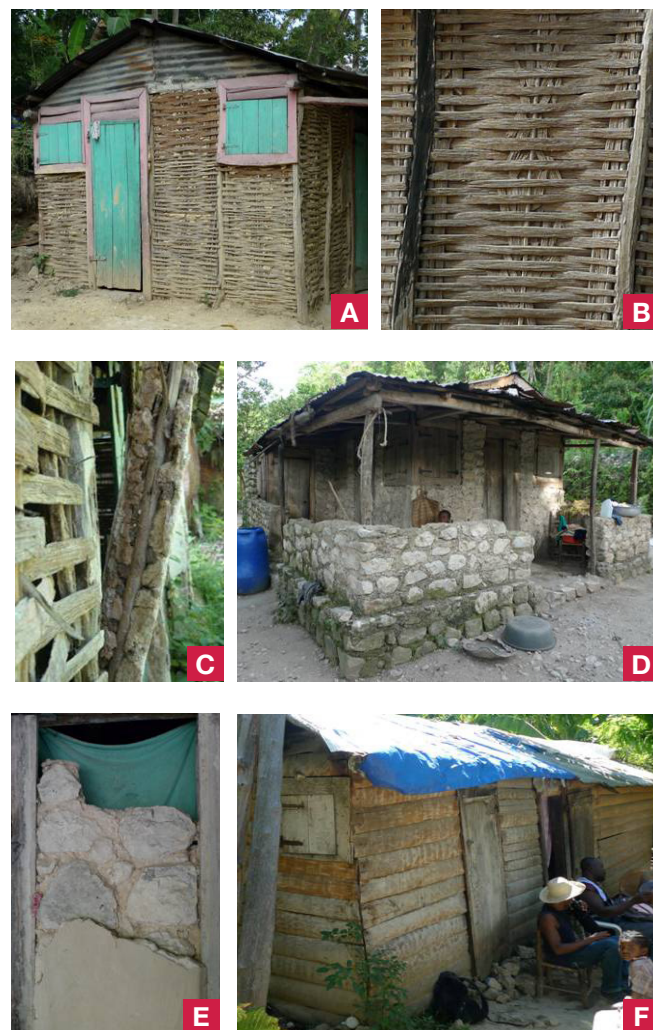
Figures 1. Techniques de construction :
