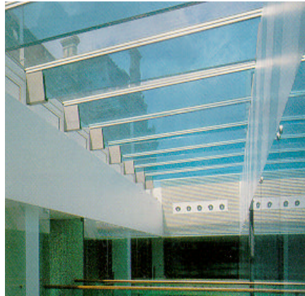
Figure 1. Exemple d'utilisation de verre structural (poutres en verre, musée du Louvre)
