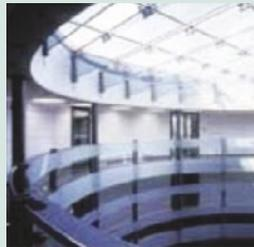
Figure 1. Poutres en verre trempé supportant une verrière
