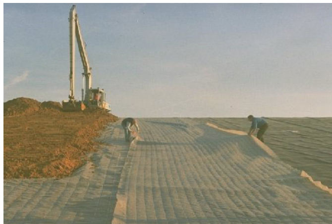
fig. 2.6. Mise en place du sol de couverture d'un DEG.
