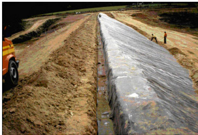
fig. 2.9. Tranchée d'ancrage (d'après [Bri01]).
